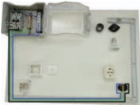
شکل ۱۰-۵- انجام سیم‌کشی پریز ۱
