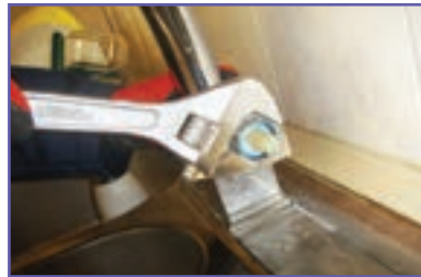
ث- باز کردن پیچ روی مغزی (گلند)
