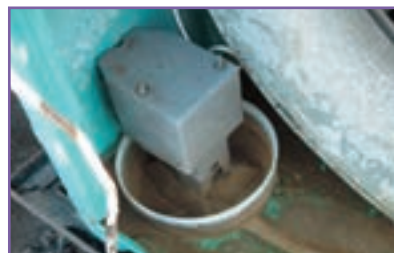
ج - بررسی و تمیز کردن پمپ آب
