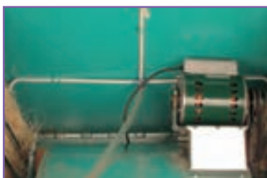
ح - آزمایش صحت مدار آب پخش کن
